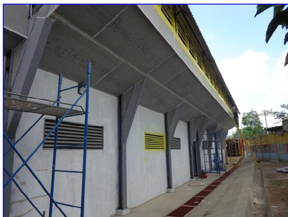
Fachada costado Oeste de la cancha de Volibol techado, donde se observa la ejecución de la etapa de ventanas, forro de durock, pintura.
