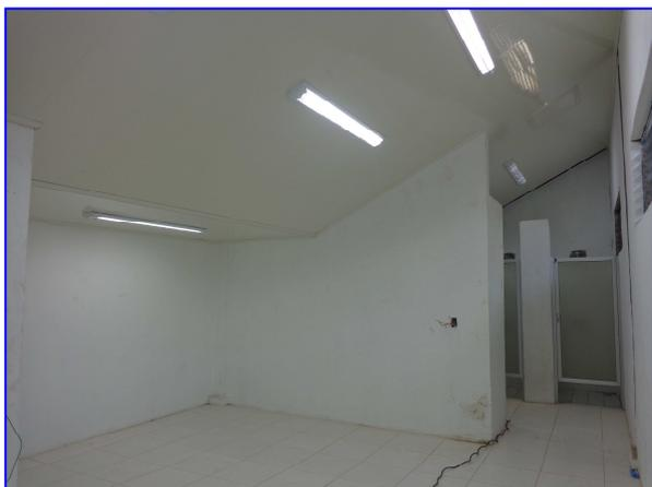
Vista interna del área de camerinos - Gradería Oeste, donde se aprecia la ejecución de las actividades de pisos, lámparas, puertas de aluminio y lámina acrílica rugosa.
